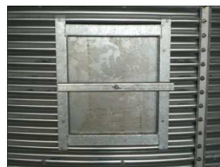
Trappe de visite
