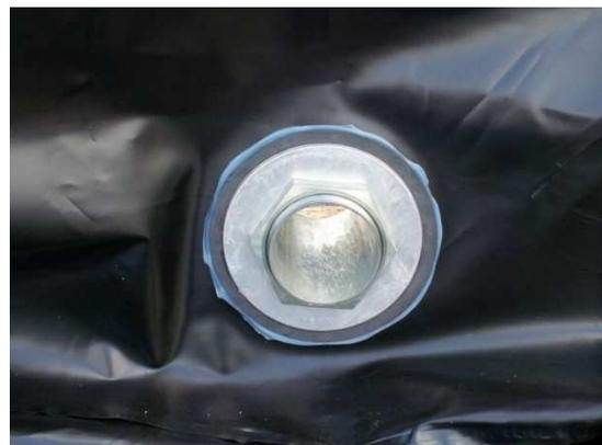
Vous pouvez mettre un mastic silicone (prévu à cet effet) ou une pâte d'étanchéité, entre le liner et les joints afin de garantir l'étanchéité.
