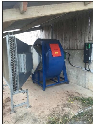
*Ventilateurs, batteries chaudes, variateurs de fréquence*
