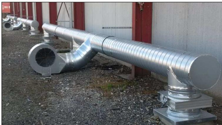
*Collecteurs d'air avec ventilateurs centrifuges*
