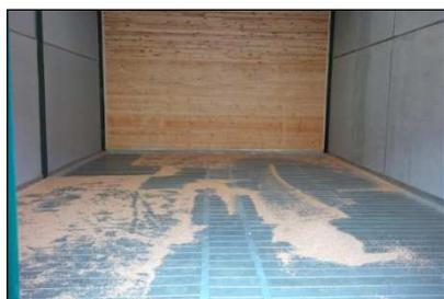
**Plancher intégral carrossable ou non** : La solution la plus polyvalente (la ventilation est uniforme sur l'ensemble de l'aire de stockage). Le coût à la construction est plus important qu'avec des caniveaux.
