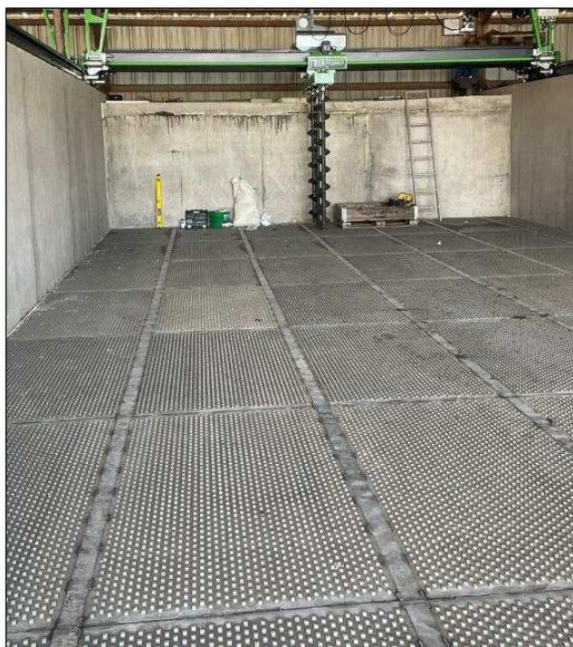
Ils sont constitués de tôles en acier galvanisé d'épaisseur 3 mm, ou en acier brut d'épaisseur 5 mm au format 1000 x 2000. Ces tôles possèdent plus de 1500 déformations (pontets) qui laissent passer l'air à hauteur de 4% (hauteur de pontet de 2mm) et offrent une grande résistance au passage d'engin.
