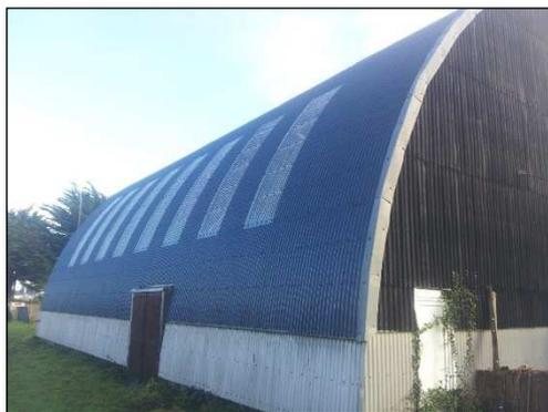
*Couverture et bardage en tôles ondulées*
