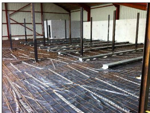
Pour assurer une ventilation convenable, le bâtiment doit être couvert et la couverture doit se situer bien au-dessus du tas pour assurer une sortie d'air suffisante. La sortie d'air doit se situer du côté opposé au ventilateur et sa surface dépend du débit du ventilateur (compter 1m<sup>2</sup> de sortie d'air par m<sup>3</sup> ventilé par seconde).
