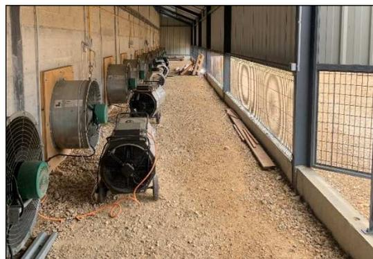
Le pilotage de cet apport d'air chaud peut être géré par l'ajout d'un hygrostat qui permet de faire fonctionner le générateur uniquement lorsque l'humidité relative de l'air ambiant est supérieure à 75% (lors des nuits ou périodes de pluie). Ces hygrostats sont faciles à trouver chez les distributeurs de matériel électrique, il suffit ensuite de le coupler à un relais qui commande le circuit d'alimentation électrique du générateur.
