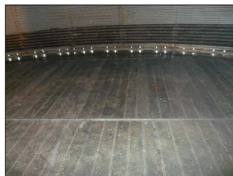
Ventilation par plancher perforé
