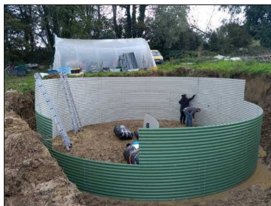
Montage réserve d'eau
