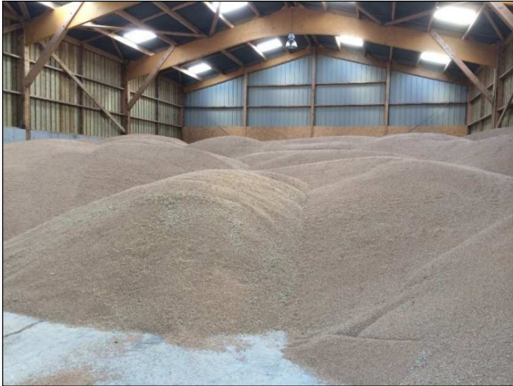
Ventilation céréales avec caniveaux
