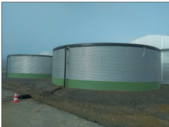
Réerves d'eau semi enterrée
