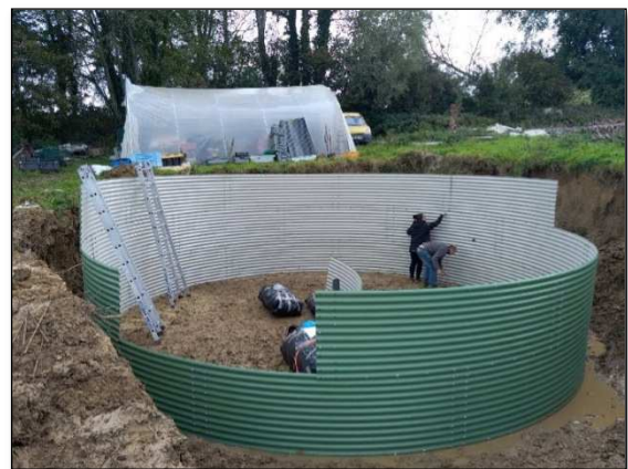
Montage réserve d'eau
