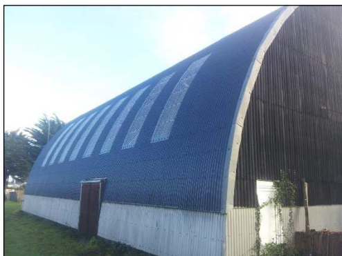
Couverture et bardage
