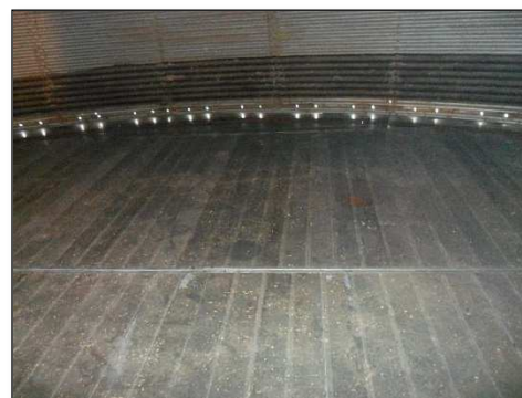
Ventilation par plancher perforé
