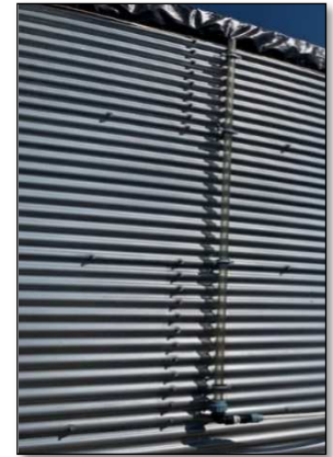
Dispositif de visualisation du niveau d'eau
