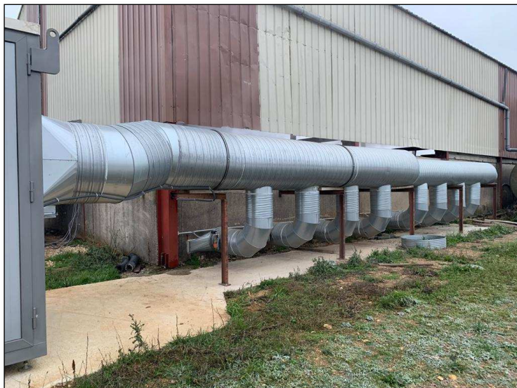
Collecteurs d'air avec planchers perforés carrossables
