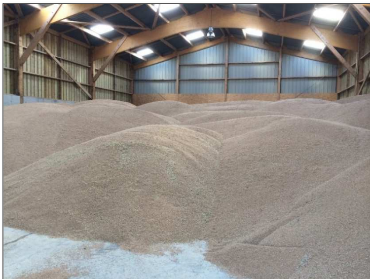
Ventilation céréales avec caniveaux
